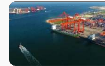
Trabajos de Dragado
